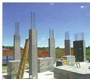
柱は木毛セメント板と共に打設
