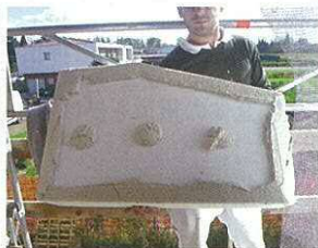
必ず断熱材の厚さをチェック
