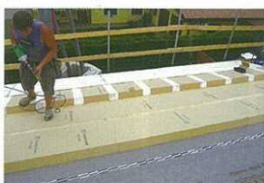
屋根断熱材ウッドファイバー240mm厚
