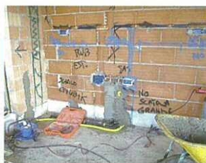
間仕切り壁下部はオートクレーブ養生した気泡コンクリートブロック。配管位置はスプレーで。レンガ造壁が、実寸の展開図になる。
